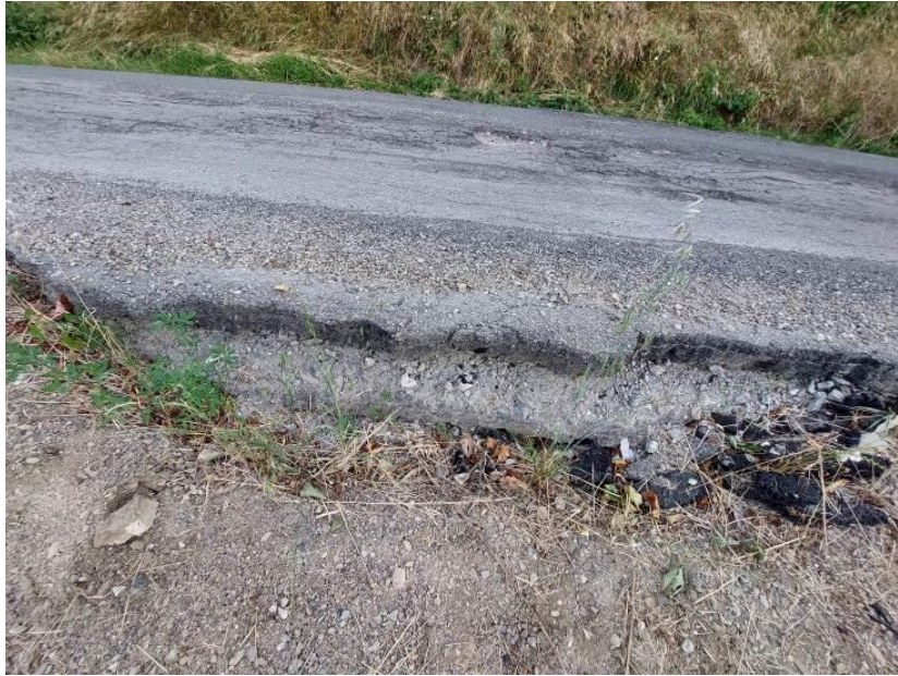
Figura 12 – Ripresa di dettaglio distacco ciglio strada
