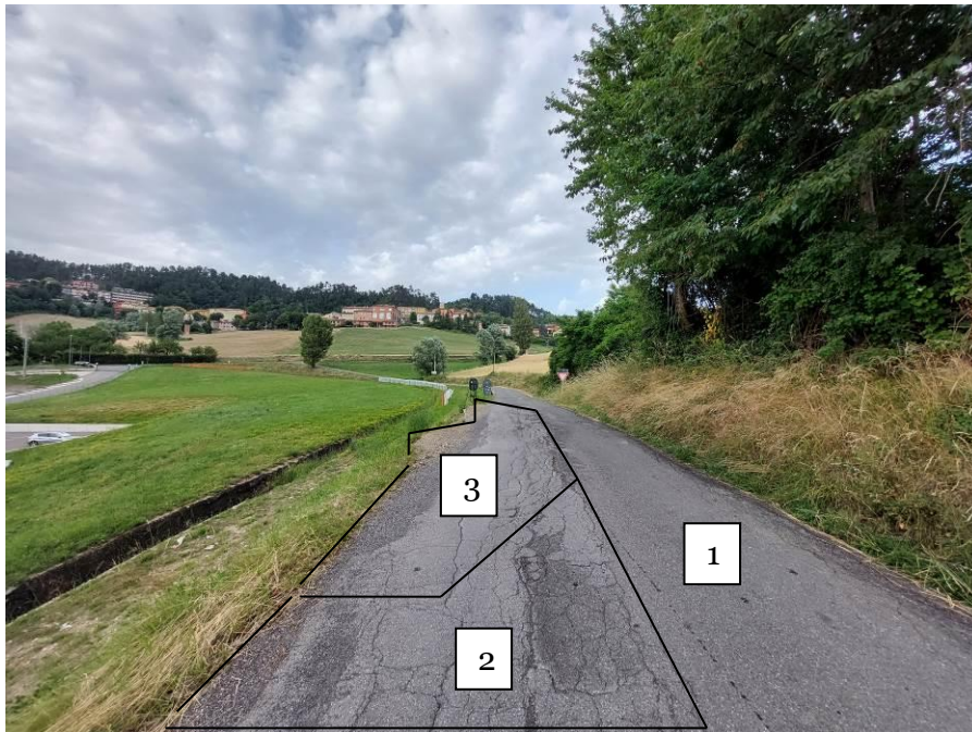
Figura 13 – Cedimenti e dissesti della sede stradale
