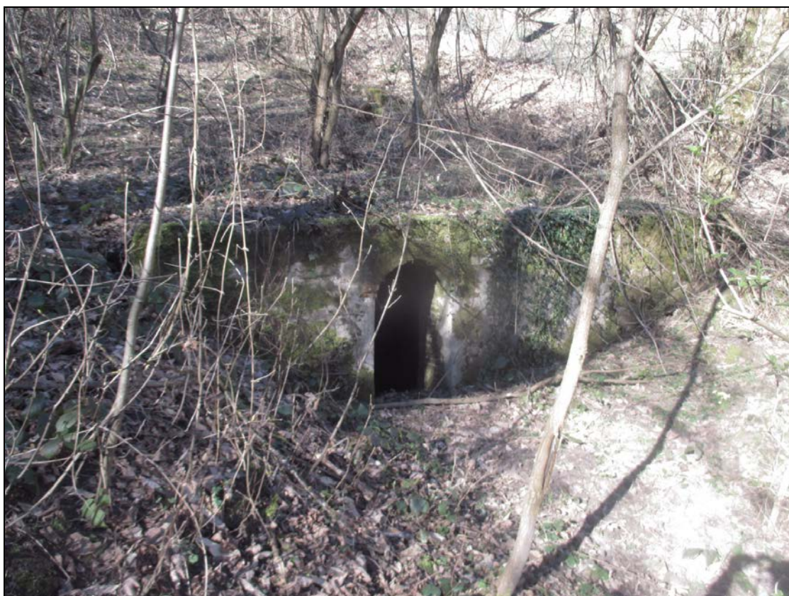
Figura 2: serbatoio in area 1 da pulire ed in cui realizzare una porta. Sostituzione della condotta che porta l'acqua alla fontana più a valle
