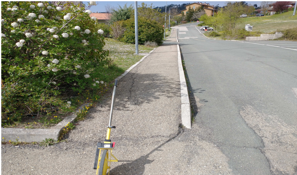
Terzo tratto di marciapiede
