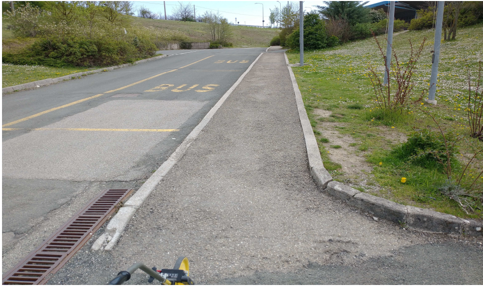
Secondo tratto di marciapiede
