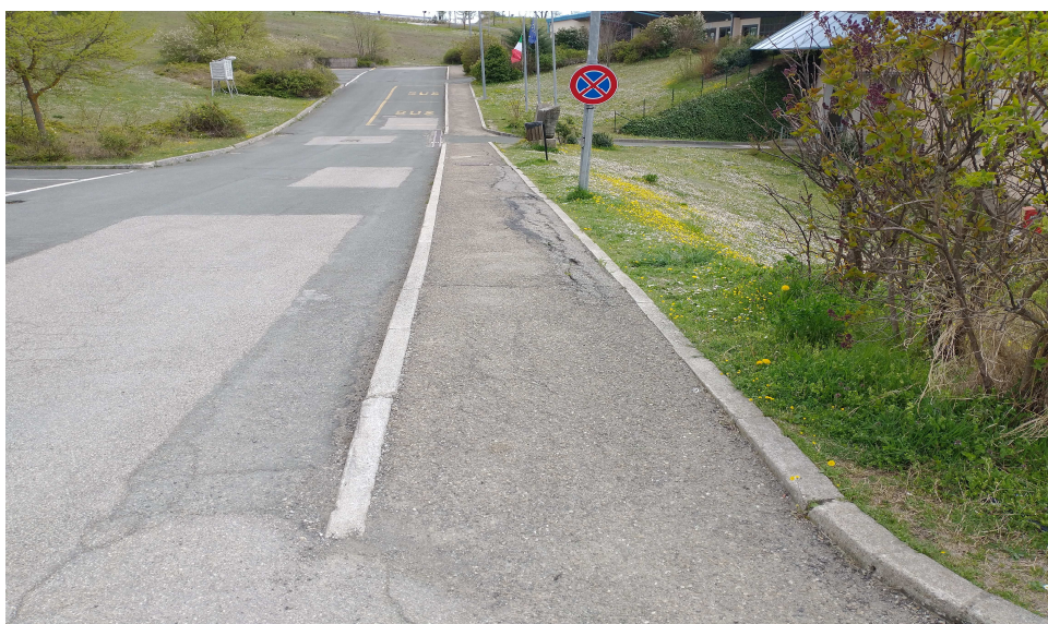
Primo tratto di marciapiede
