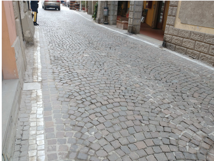
Figura 2- Esempio di porzione di pavimentazione per la quale si prevede il rifacimento utilizzando il materiale recuperato
