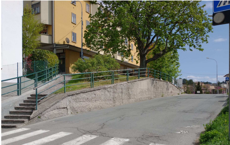
Figura 3- Muro di contenimento Viale Marconi
