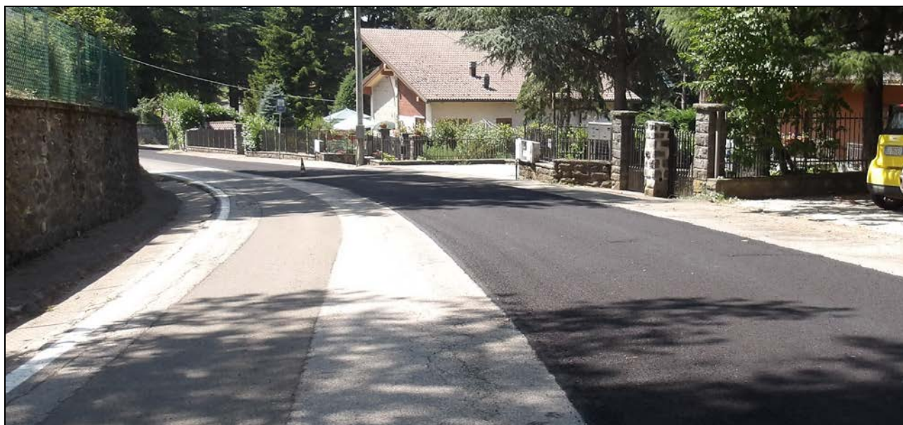
Figura 5: stesa del microtappeto monostrato sulla mezzeria di valle di un tratto di Via Madonna dei Boschi
