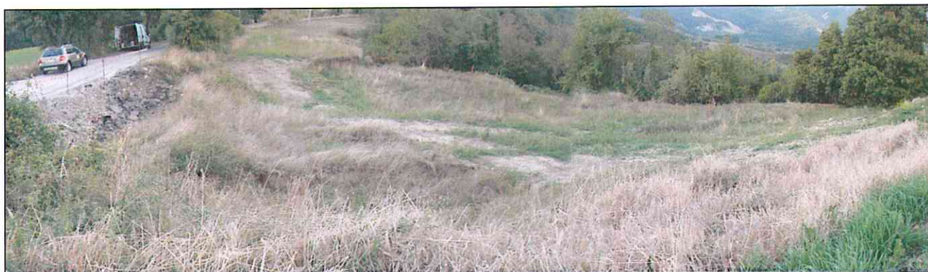
Figura 15 – fotografia della testata di frana al 02/10/2013
