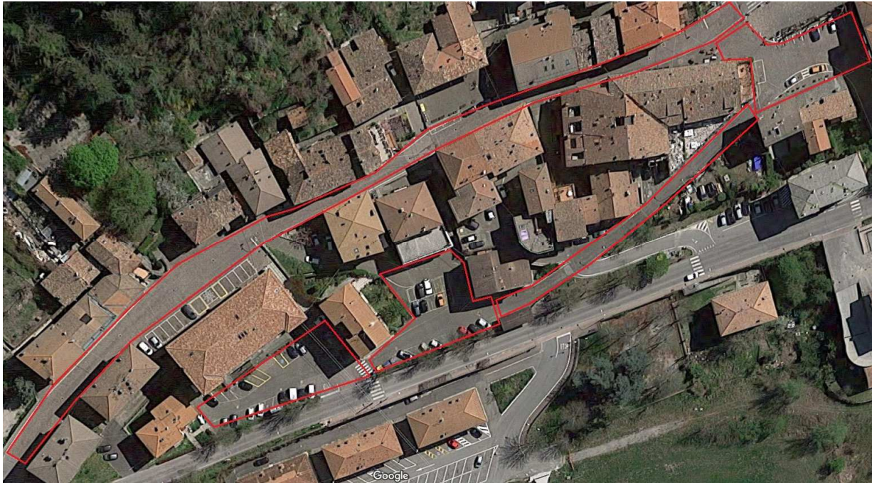
Figura 3- Aree pavimentate in porfido interessate dagli interventi
