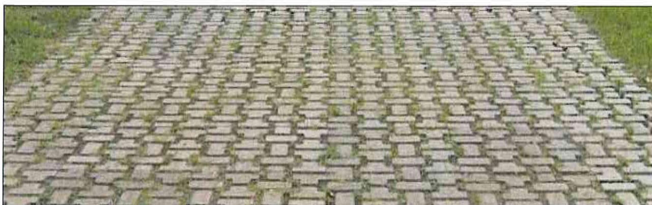
Figura C: schema di pavimentazione in grigliato erboso carrabile costituito da elementi di cls prefabbricati non legati
