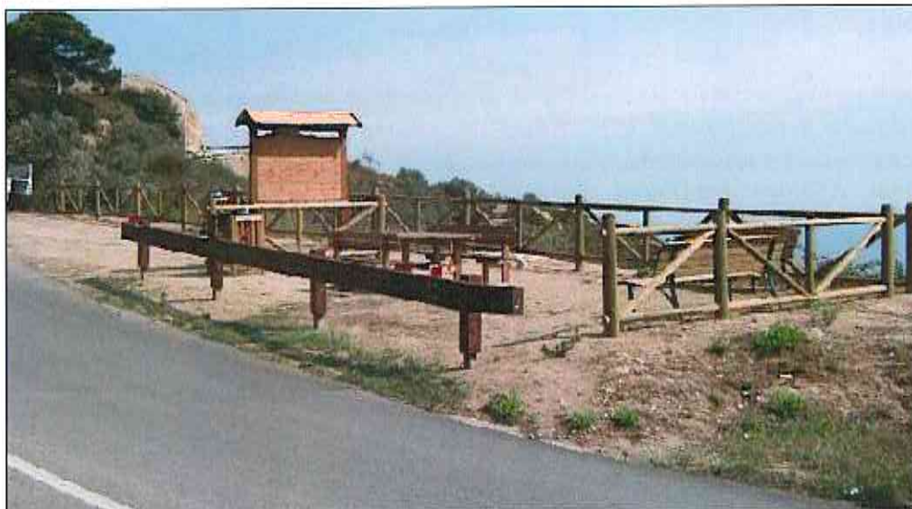
Figura I: esempio di utilizzo di guard-rail coperti in legno per la protezione dell'area attrezzata non pavimentata
