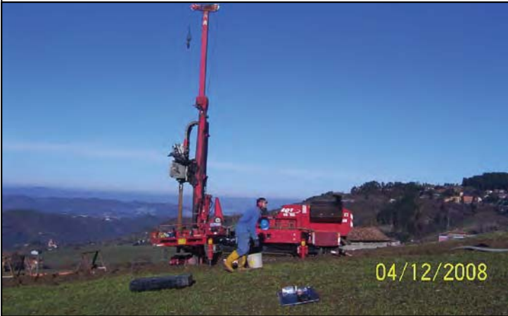
POSTAZIONE SONDAGGIO S1
