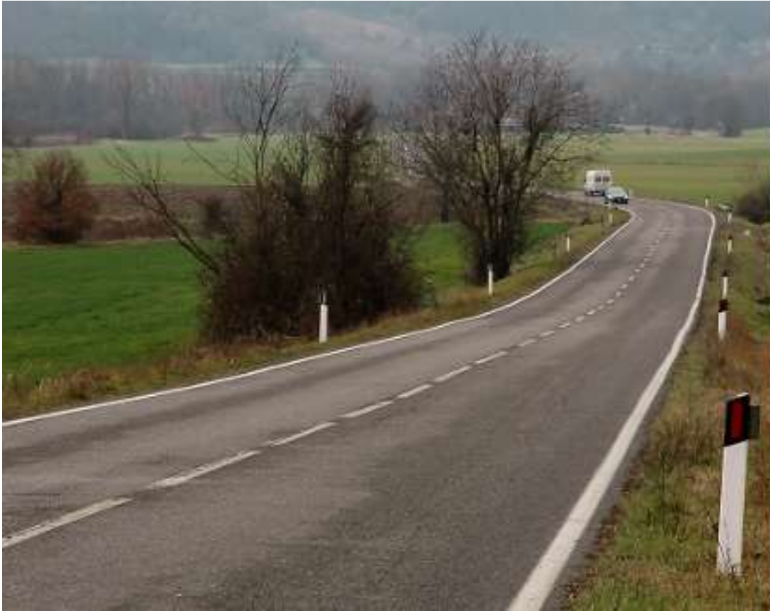
1.7.2-F6 Dissuasori elettronici alternati a catarifrangenti nel tratto di Castelnuovo Fogliani (Piacenza).
